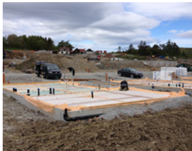
Byggeplass, boligprosjekt på Kleivane i Sandnes.
