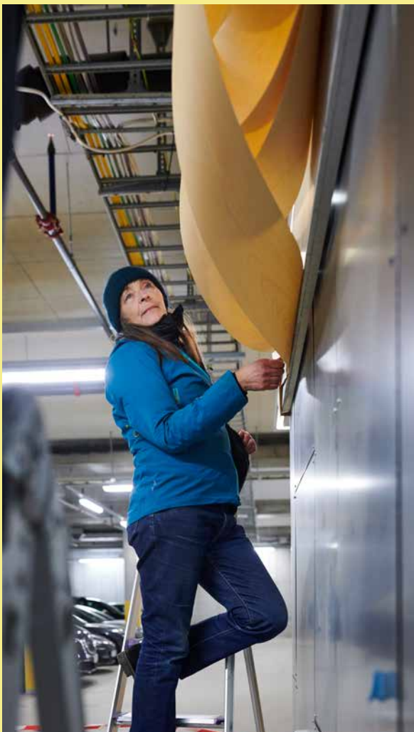
Kunstner Hilde Hauan Johnsen under monteringen av kunstverket Bølge, blomst og sammenvevde bånd på Glasblokkene, Haukeland universitetssjukehus. © Hilde Hauan Johnsen / BONO. Foto: Pål Hoff.
