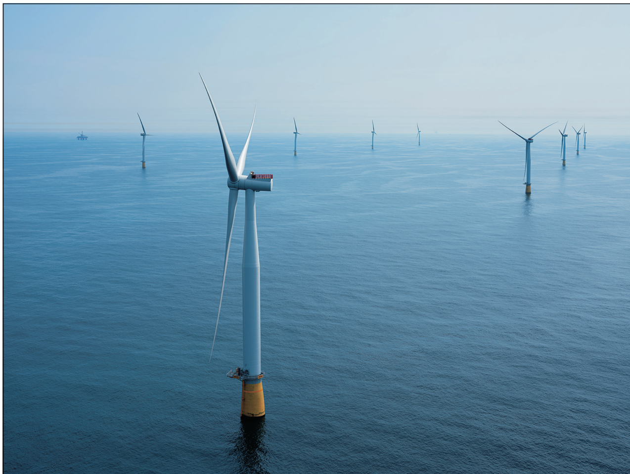
Figur 5.8 Flytende vindturbiner, havvindparken Hywind Tampen
